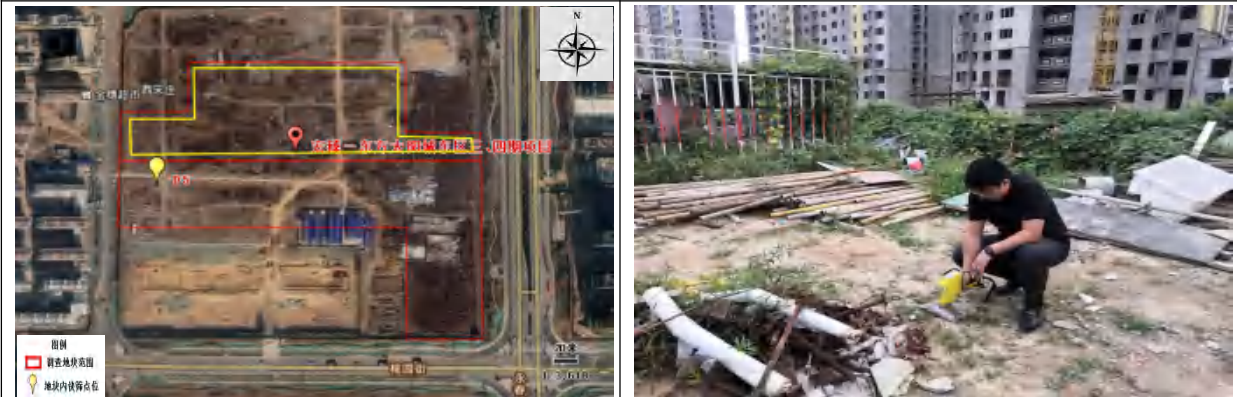
简介：四期项目地块西部区域，施工耗材（金属管材）堆放处快速检测点位。
