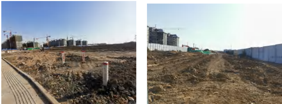
图 4.2-1 现场踏勘照片
