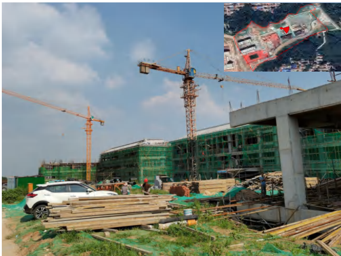
本地块内东侧：已完成建筑物的主体结构。
