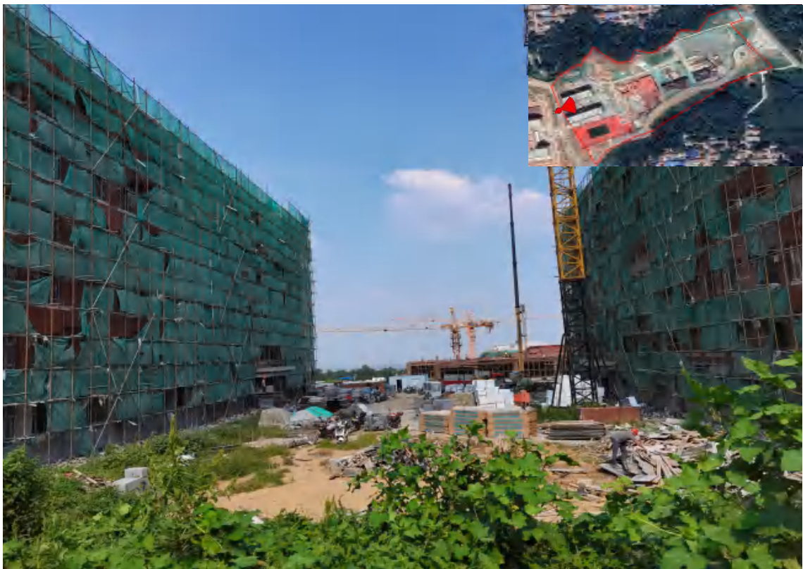
本地块内西侧：已建成西侧两幢建筑物的主体结构，
