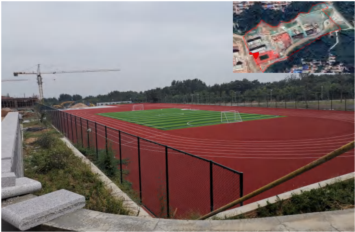
本地块内西南侧：操场已铺设完成。
