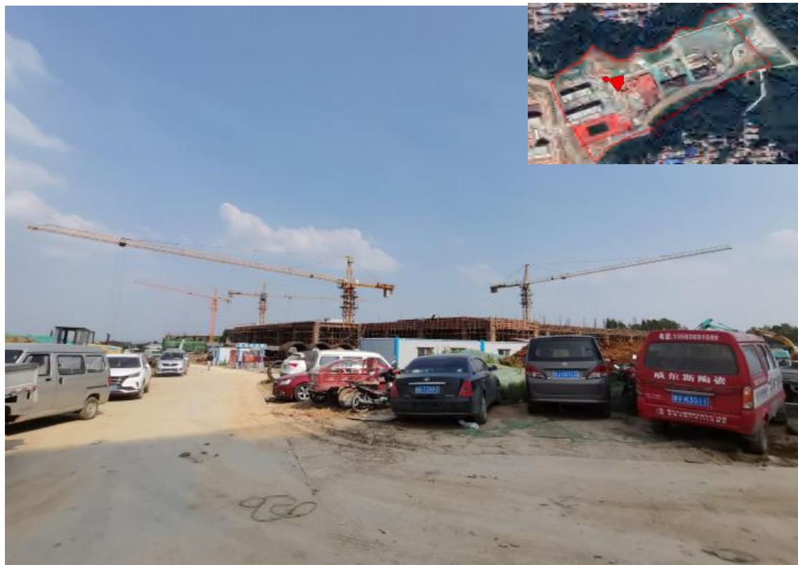
本地块内中部：已完成地下防水工程，开始建设主体结构。
