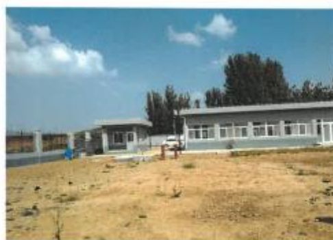
现场查勘照片
