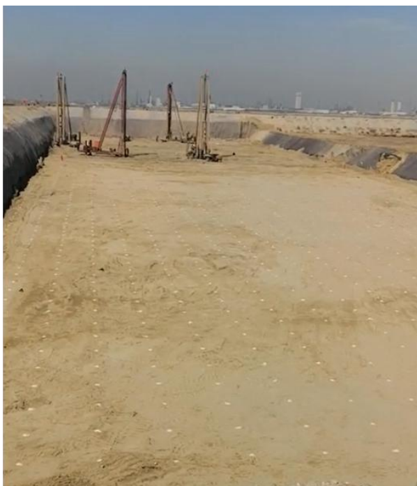
4月份，载体桩复合地基施工，共打载体桩约2592棵
