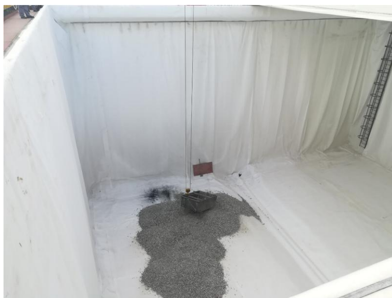
11月份，导滤石子铺装完成
