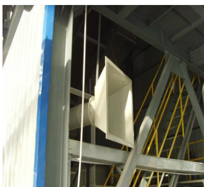
固化废气集气罩
