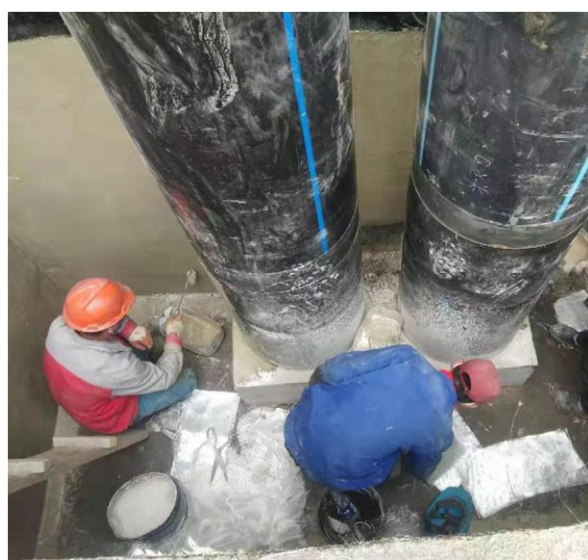
9月，渗滤液导排系统安装完成
