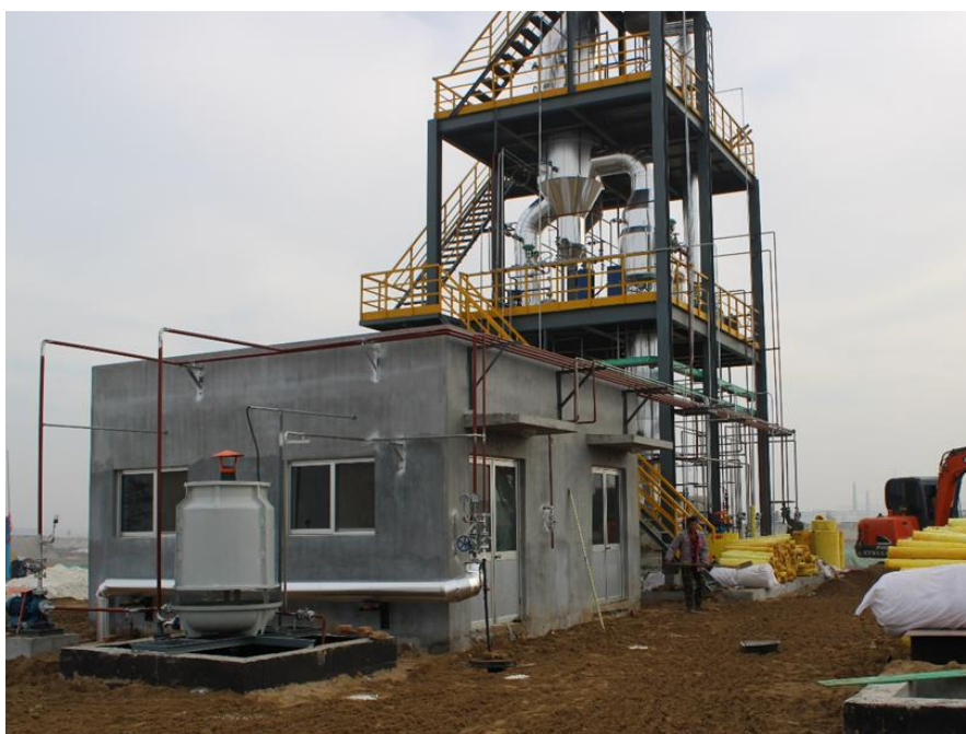
10月 MVR 设备安装完成，水池建设完成（长 25.6m 宽 19m 高 5.5m）
