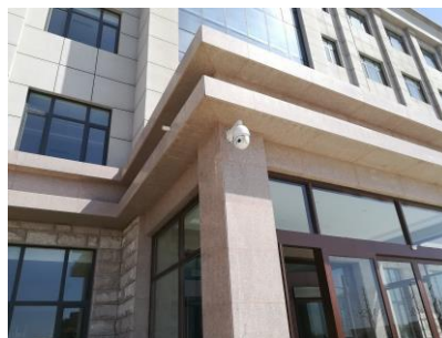
办公楼摄像头
