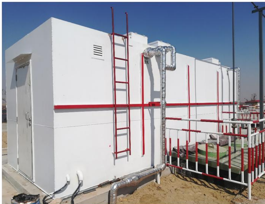
10 月份，集成生化处理一体设备安装完成
