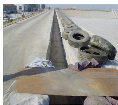
填埋区导洪沟
