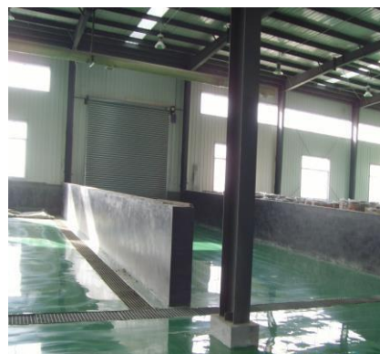
危废暂存库分区
