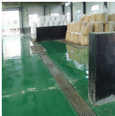
危废暂存库分区及导排沟
