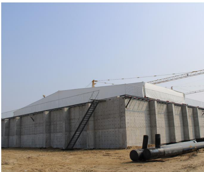
9月，防雨棚吊装完成
