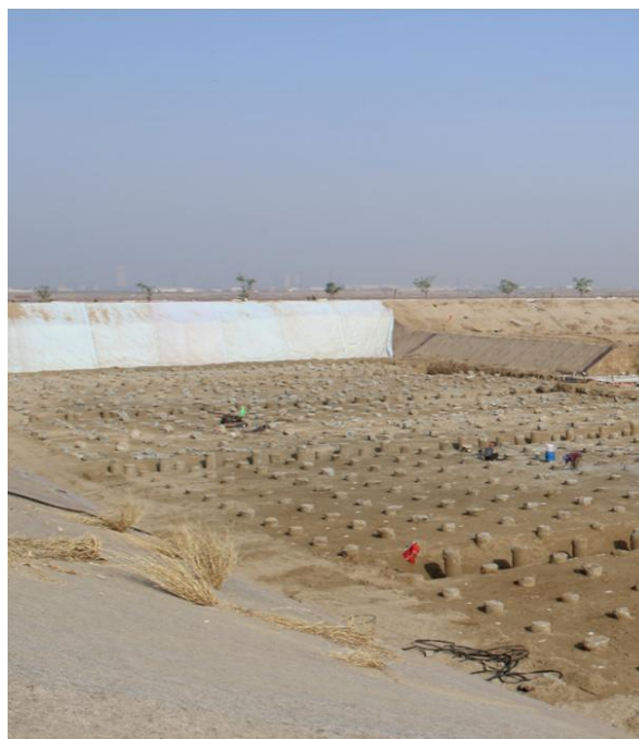
4月份，载体桩复合地基施工，共打载体桩约2592棵
