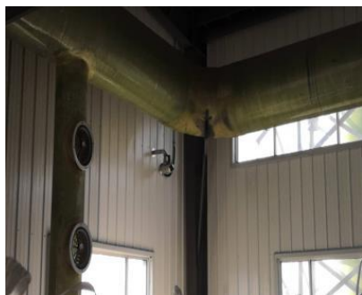
暂存库摄像头
